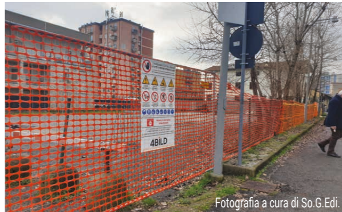
Il cantiere della Casa di comunità in via Lecco
