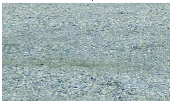
Pavimentazione in calcestre
