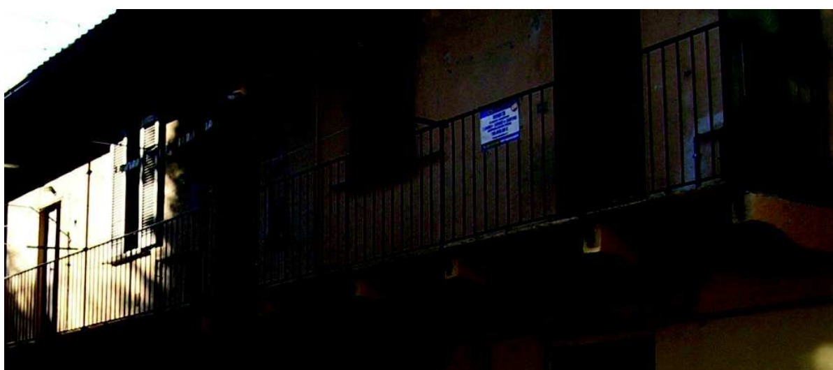
Fotografie di balconi isolati e di balcone continuo a ballatoio
