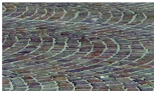
Pavimentazione in pietra naturale
