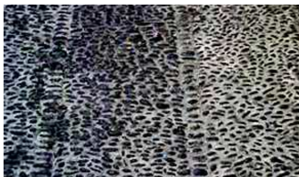
Pavimentazione in acciottolati/rizzada
