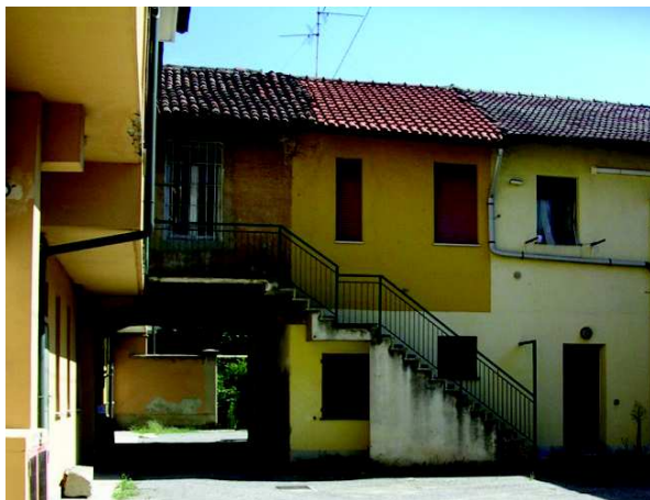
Schema di scala esterna con pedata in pietra naturale e parapetto in ferro
