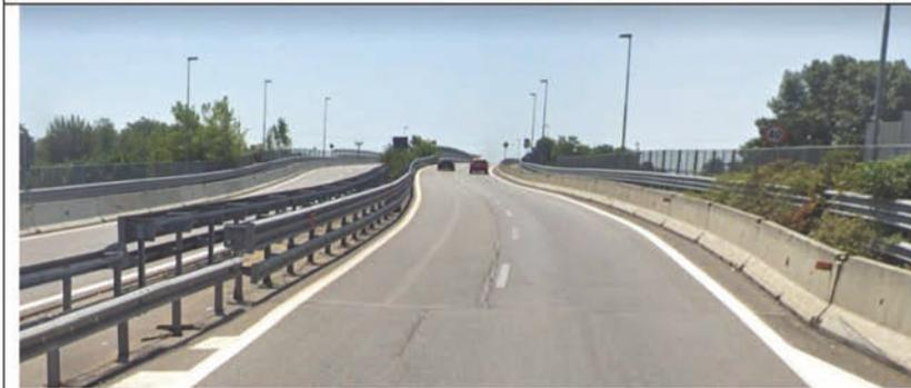
L'ampiezza del manufatto è occupata, oltre che dalle due corsie, da un ampio franco laterale protetto da jersey e da una riserva centrale protetta da una doppia barriera.
