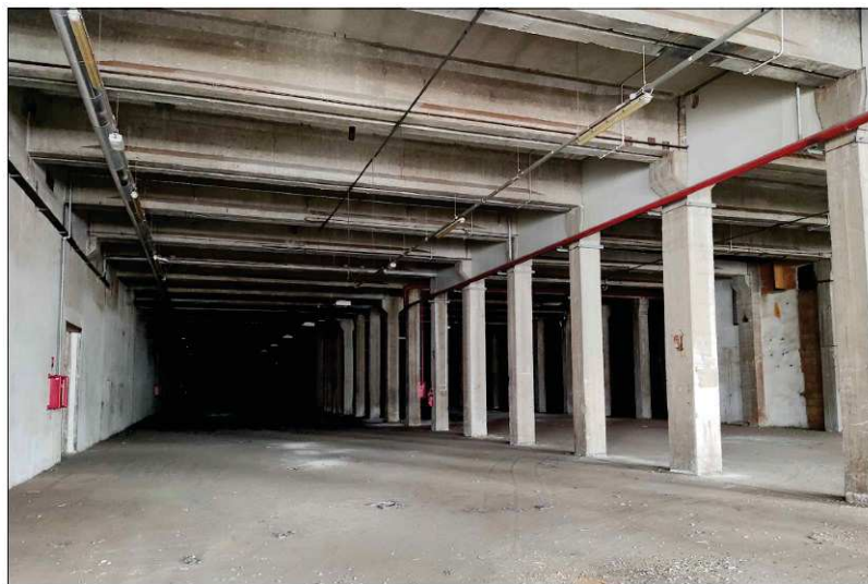
Figura 9: Vista del piano interrato del corpo 8
